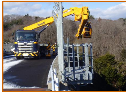
橋りょう点検車による検査
