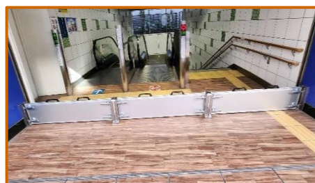
東西線仙台駅に配備した止水板
