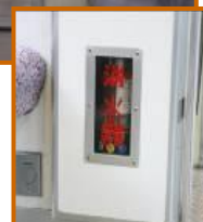
車内の消火器
