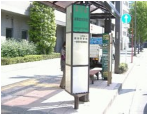
写真⑥ 電照式標識
