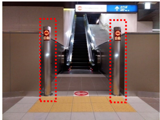
写真④ ポール式案内装置(八乙女駅)
