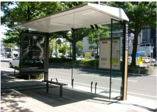
写真⑦ 上屋・ベンチ
