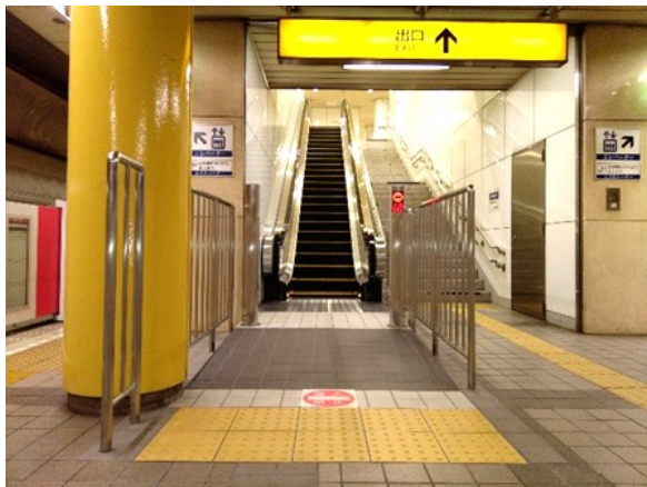
写真① 下りエスカレーター増設(五橋駅)
