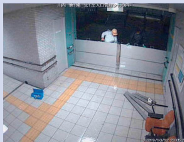
出入口に止水板を設置
