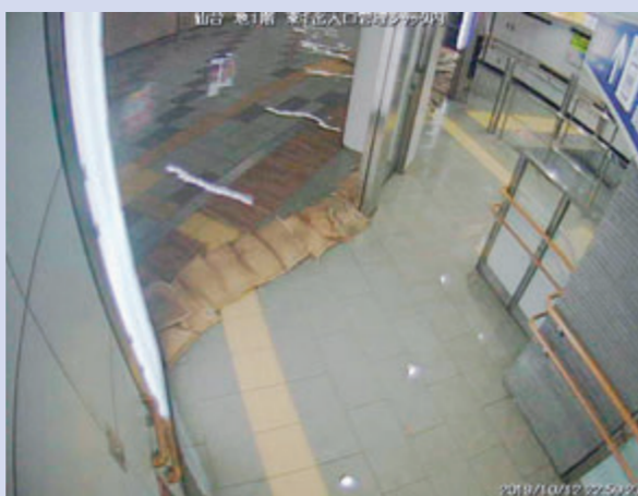
土のうを設置
