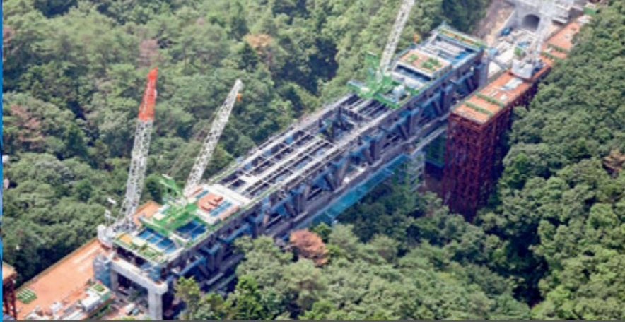
竜の口橋りょう工事(トラベラクレーン張出し架設)
