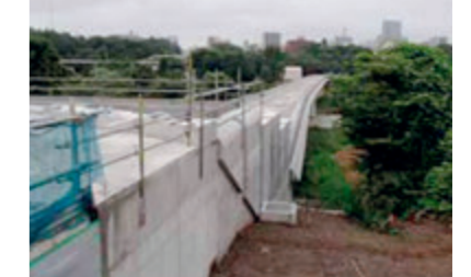
広瀬川よう壁(約23m)/広瀬川橋りょう(約172m)/西公園高架橋(約118m)/西公園よう壁(約87m)
