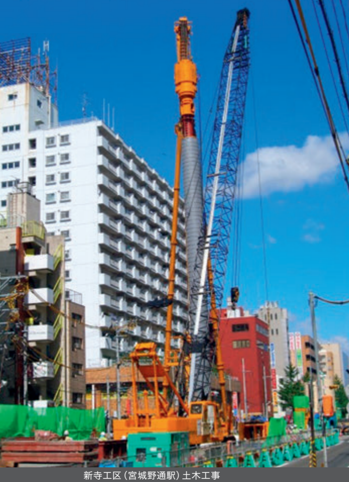
新寺工区(宮城野通駅)土木工事
