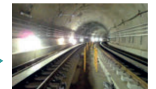
レールとリアクションプレートの敷設が完了した八木山トンネル。敷設が完了した八木山トンネル。敷設が完了した八木山トンネル。
