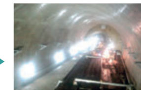
地下に投入されたレールを溶接基地で溶接。継ぎ目の無いロングレールにしてから敷設。
