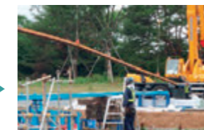
現場に運搬されたレールはクレーン車で吊るされ、レール投入シューターに移された。
