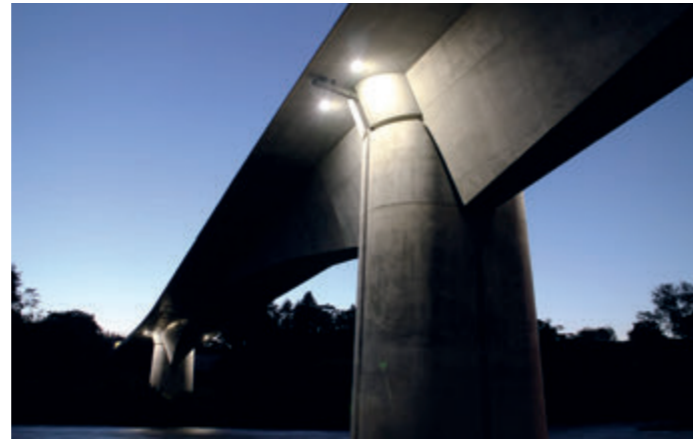
広瀬川橋りょう
