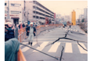
阪神淡路大震災の被害状況を視察
