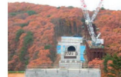
竜の口橋りょうの桁等の製作、運搬、架設(約160m)
