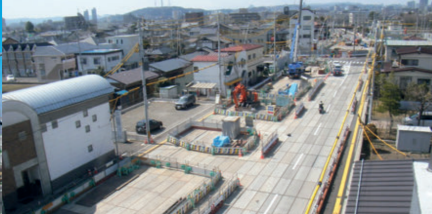
薬師堂工区(薬師堂駅)土木工事
