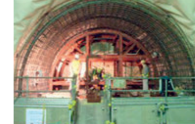
青葉山トンネル(竜の口橋りょう～青葉山駅間/約1,120m)及び竜の口橋りょう下部工
