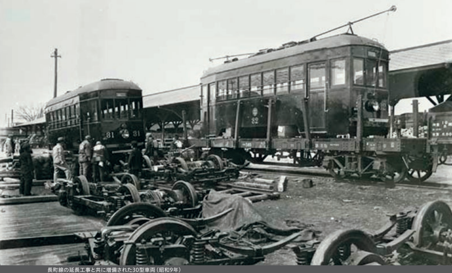
長町線の延長工事と共に増備された30型車両(昭和9年)
