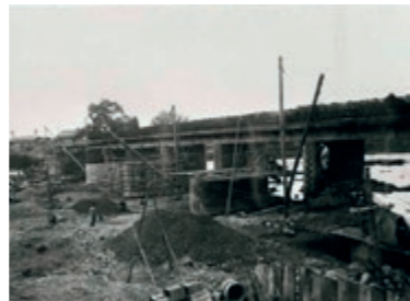
広瀬川電車専用橋の橋脚工事
