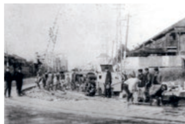
荒町～愛宕橋間建設工事土樋カーブ付近(昭和8年)
