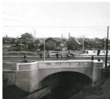
長町線七郷堀付近軌道敷設工事
