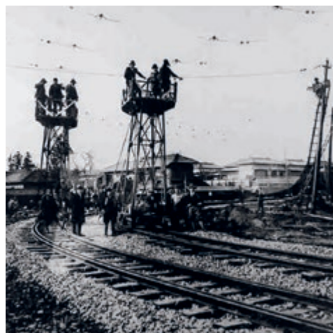
土樋カーブ架線工事
