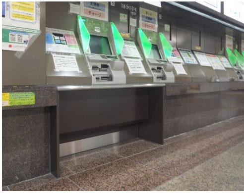
写真① 券売機カウンターの改修 (南北線仙台駅)
