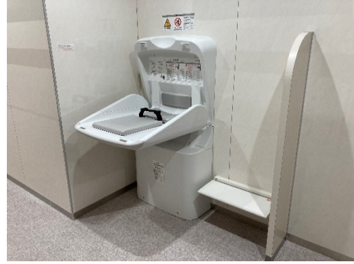
写真② おむつ交換台の設置 (南北線愛宕橋駅)
