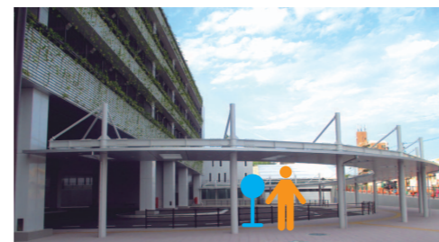
バスのりばには屋根を設置
