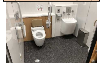
男女トイレ内の便房
