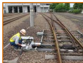
電気転てつ機検査
