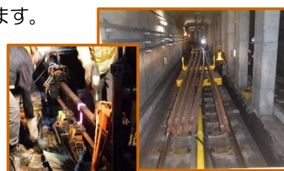
レール溶接・レール運搬作業
