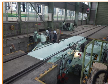
設備更新作業の様子
