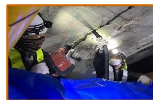
導水補修（止水）工事
