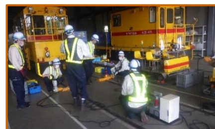
軌道特殊車脱線復旧訓練
