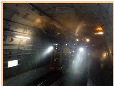
トンネル内洗浄
