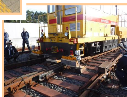
軌道特殊車脱線復旧訓練
