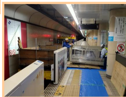
夜間工事の様子
