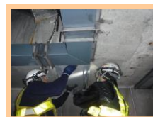
導水樋設置作業
