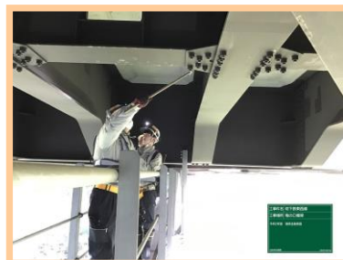
橋りょう検査
