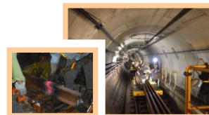
レール圧接・運搬作業
