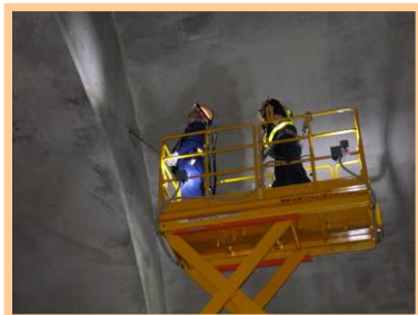
トンネル打音検査
