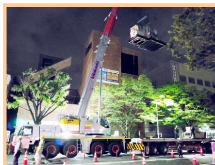
夜間工事の様子
