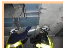
導水樋設置作業
