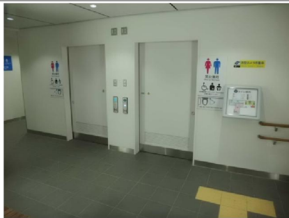
写真⑤ 手すりが左右対となっている ひろびろトイレの設置
