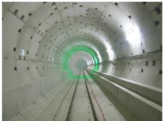
新寺工区の工事状況
