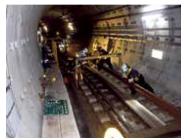
レール交換作業
