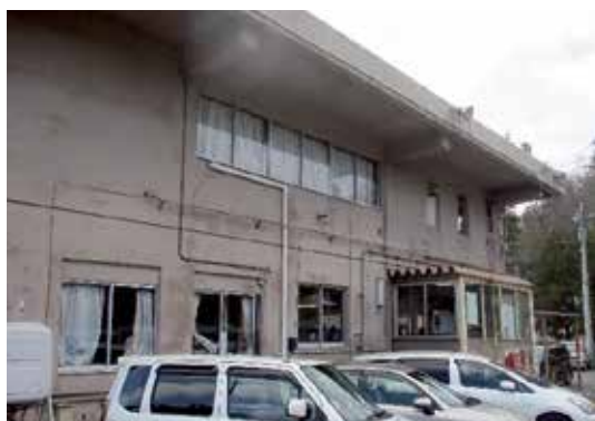
老朽化が進む川内営業所
