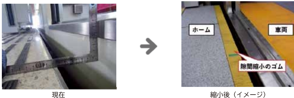
南北線駅ホームと車両間の隙間と段差の縮小
