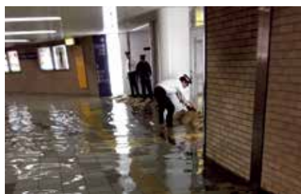
令和元年東日本台風の被害（地下鉄）
