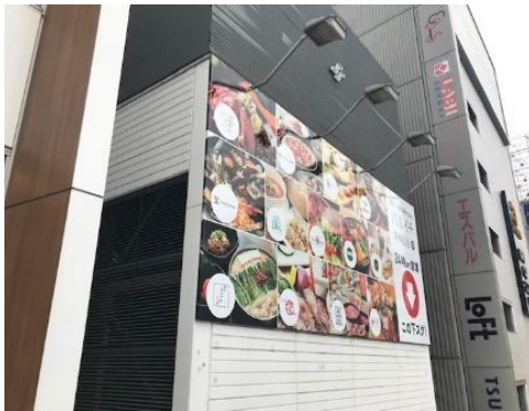
仙台駅換気塔
