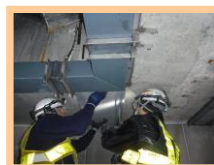
導水樋設置作業
