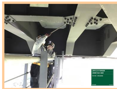
橋りょう検査
