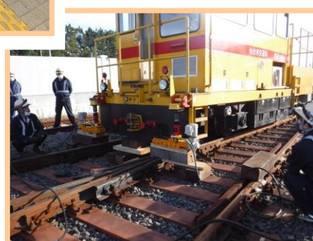
軌道特殊車脱線復旧訓練
