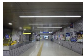
地下鉄駅舎内の LED 化
