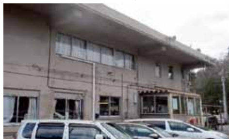
老朽化が進む川内営業所
