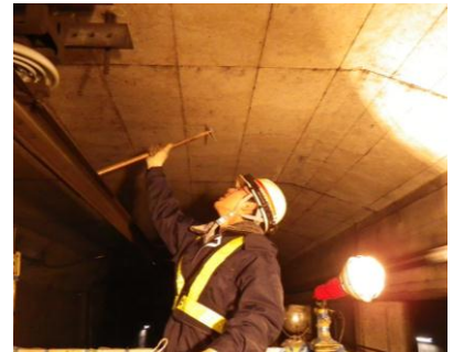
◆トンネル検査
