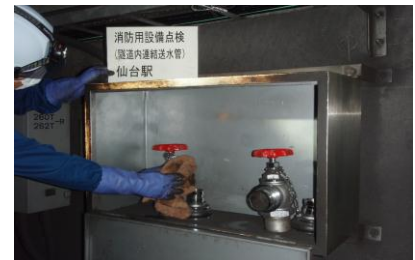
◆消防用設備点検
