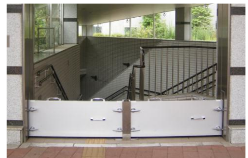
◆駅出入口に設置した止水板
