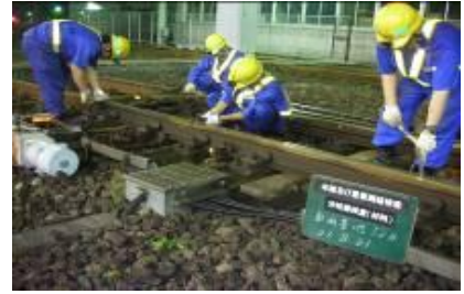
◆分岐器(ポイント) 検査
