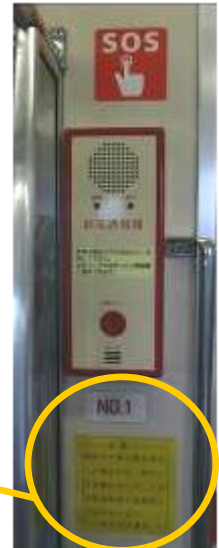
◆ 車内非常通報器
