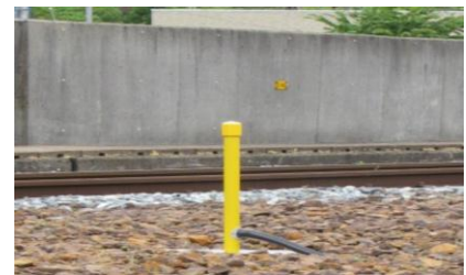
◆限界支障検知器
