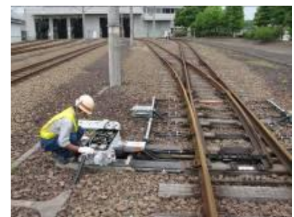
◆電気転てつ機検査
