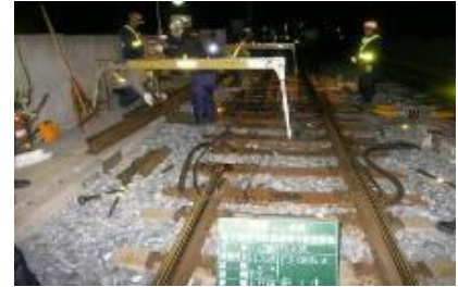
◆レール交換作業
