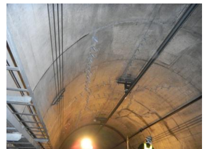
◆樹脂系注入工事
