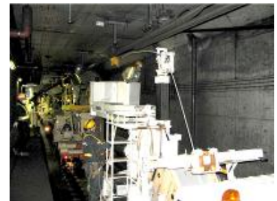
◆トンネル内でのトロリー線交換作業
