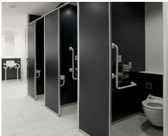
写真⑩ ブース内手すり
