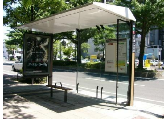
写真⑨ 上屋・ベンチ
