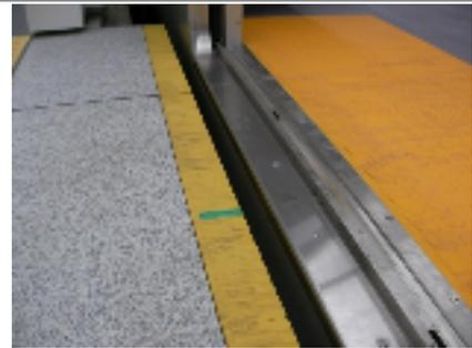
写真⑥ 車両とホームの隙間の縮小化
